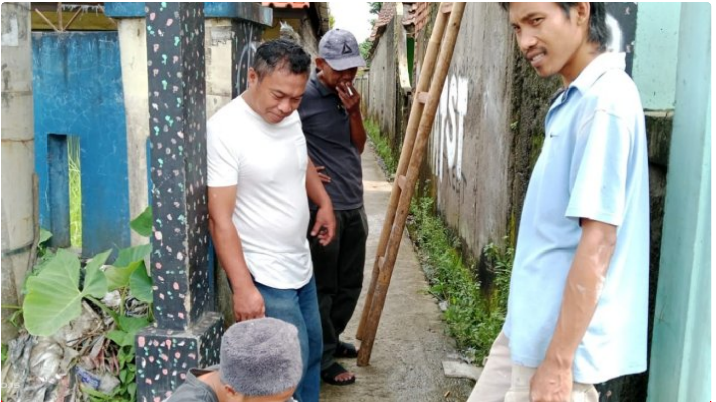
Warga di Cibadak Gotong Royong Pasang Lampu Jalan Gang
