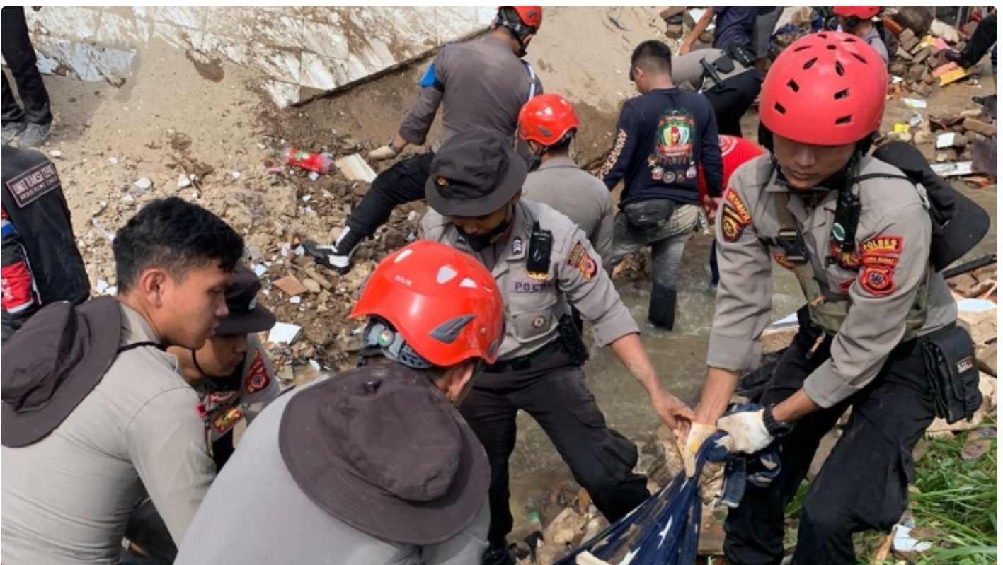
Personil Satuan Samapta Polres Sukabumi, Evakuasi Puing Reruntuhan Rumah yang Diduga Masih ada Korban Akibat Gempa Cianjur
