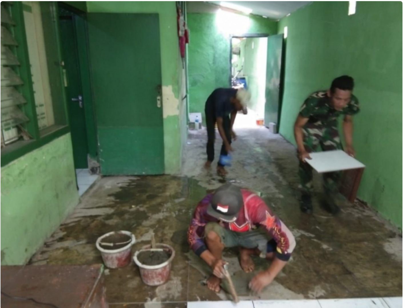
Koramil 0622-04/Cikidang Lakukan Perbaikan dan Pemeliharaan Kantornya
