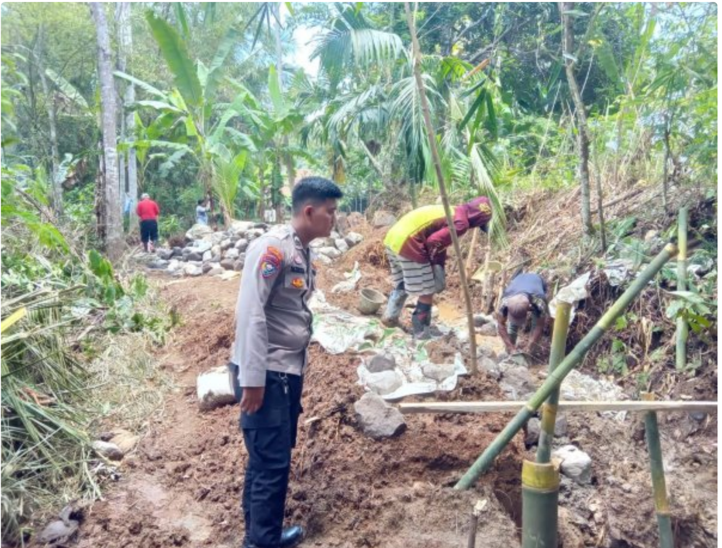
Bhabinkamtibmas Cijengkol Memantau Pembangunan Irigasi di Wilayah Desa
